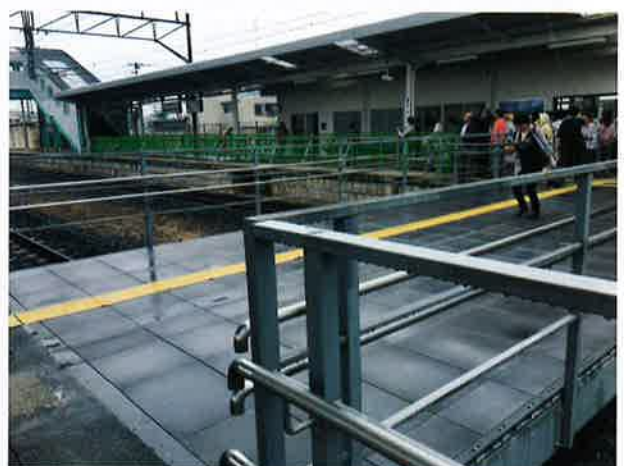
いまだ開通しない常磐線「浪江駅」 線路上の仮設通路
