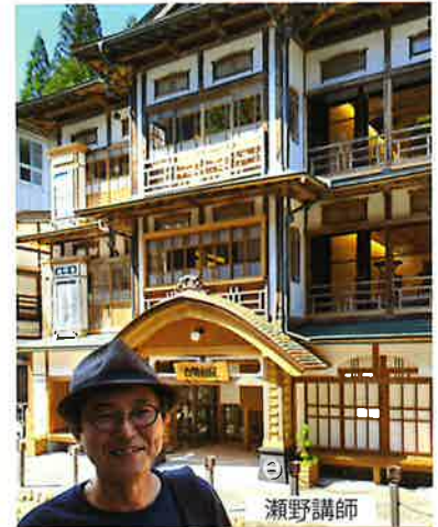
街並みを変えない老舗温泉の旅館の大改修。银山温泉 古勢起屋本館 撮影：井澤豊隆
