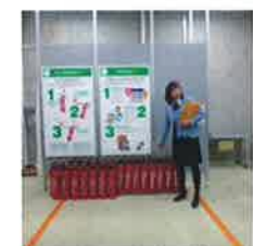
消火器には水が入っています
